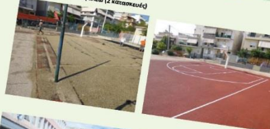
5 ο Δημοτικό Σχολείο Αγιάλεω (2 κατασκευές)
